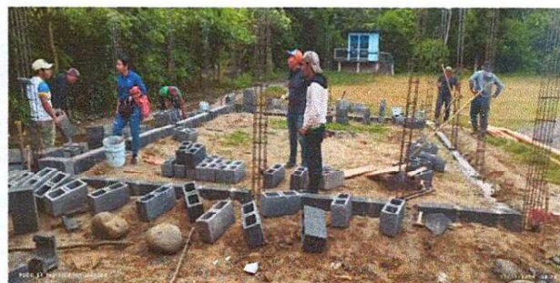
Foto 2: TIRANDO EL SIMIENTO DE LAS BASES Y ORCONES
