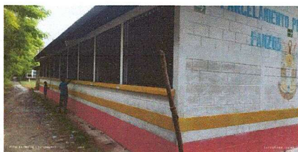
Foto 3: DANDO LE MANTENIMIENTO A LOS VALCONES
